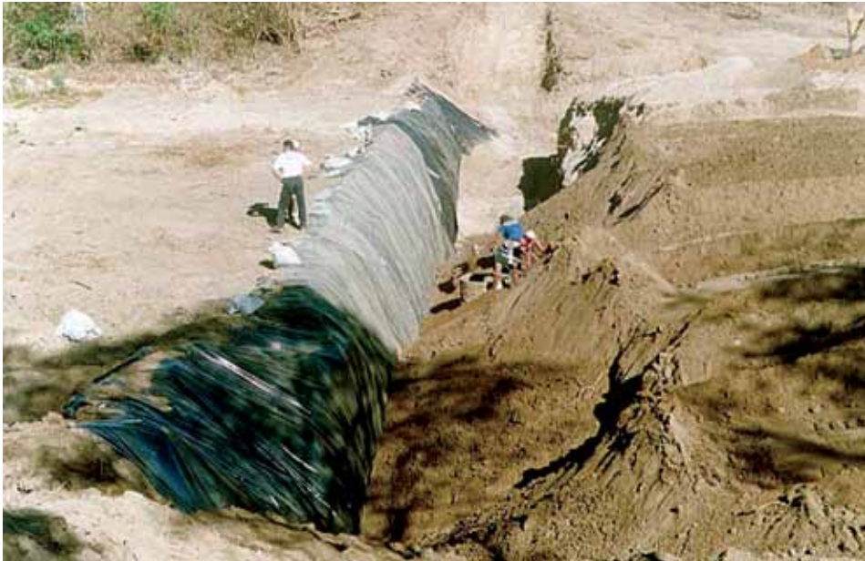
Foto 10 – Disposição da Lona de uma Barragem Subterrânea
