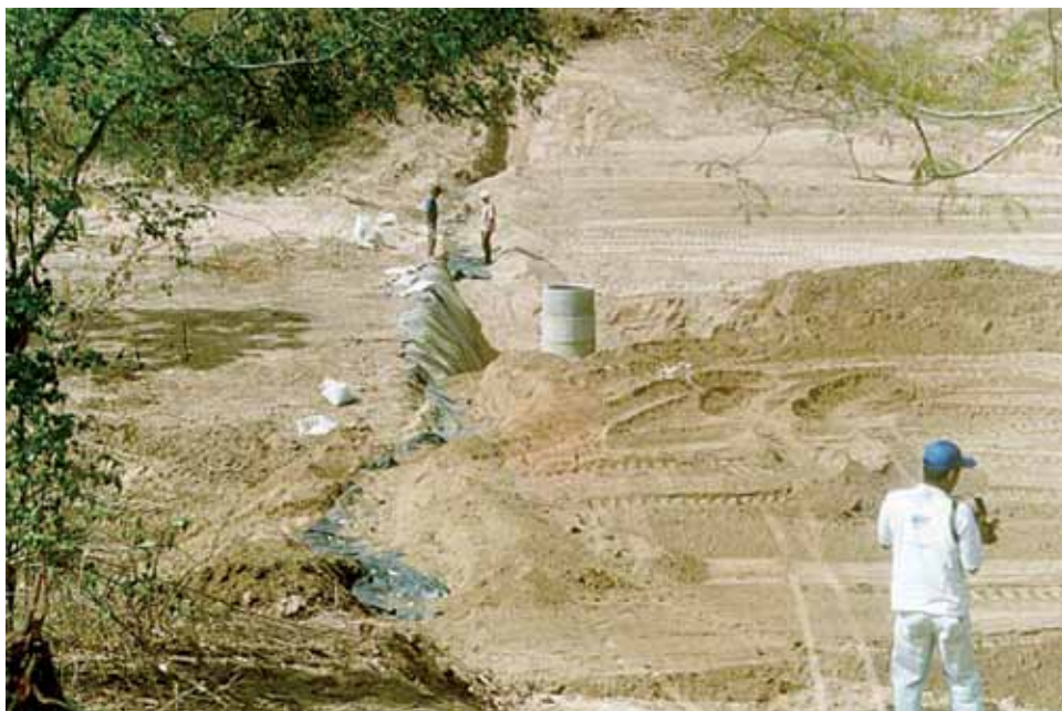
Foto 11 – Etapas de Conclusão da Barragem Subterrânea Fonte: João Bosco de Oliveira.
