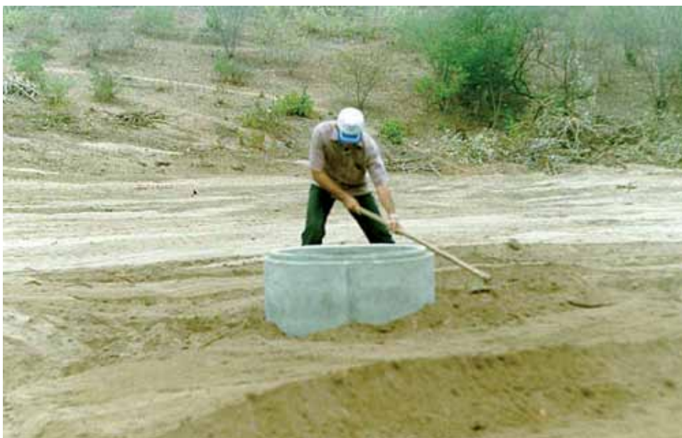
Foto 12 – Etapas de Conclusão da Barragem Subterrânea Fonte: João Bosco de Oliveira.
