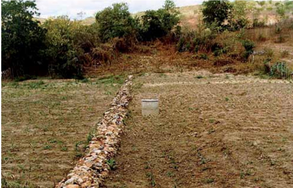
Foto 13 –Aproveitamento da Barragem Subterrânea com Capineira Fonte: João Bosco de Oliveira.
